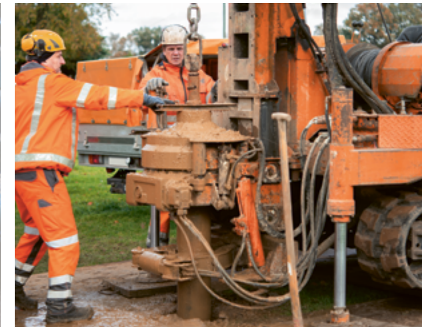
Oben: Dokumentation der Bodenfolge aus dem Hohlgestänge einer Kleinrammbohrung Unten links: Spitze einer Sonde für die Rammsondierung Rechts: Rammkernbohrung zur Erkundung der Schichtenfolge des Bodens
